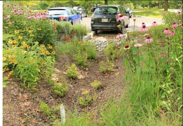
Les bassins de biorétention sont inspirés des jardins de pluie. Ils peuvent comprendre des drains souterrains pour transporter le débit excédentaire vers le système d'eaux de ruissellement ou un stockage souterrain (p. ex., couches de gravier) afin d'en accroître la capacité de rétention.
