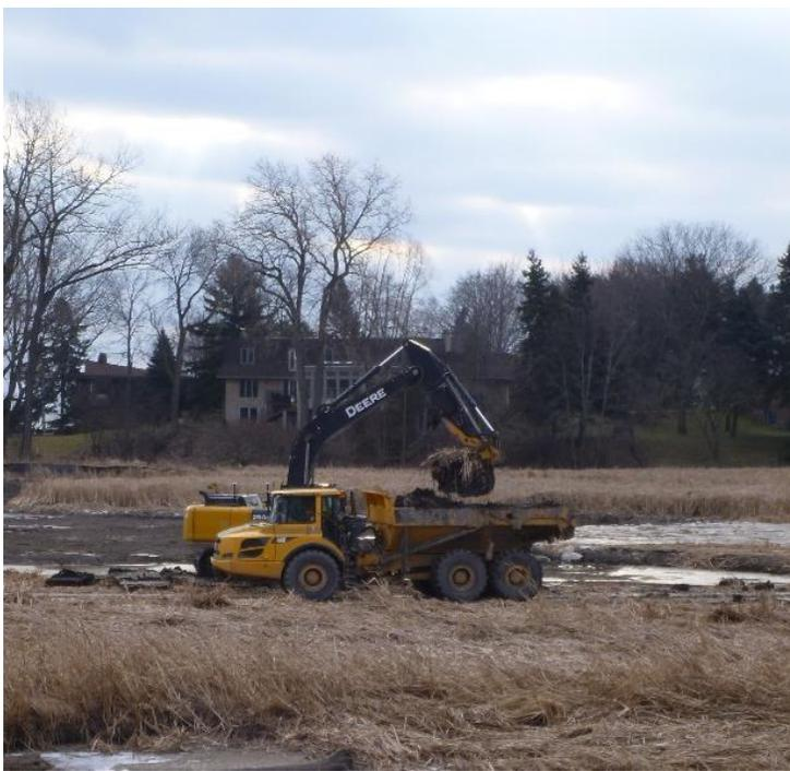
**Figure 49** : Retrait de sédiments du marais Rattray. En 2014 et en 2015, CVC a dépensé environ 2,5 millions \$ en coûts de construction, à eux seuls, pour retirer les sédiments excédentaires du marais Rattray.
