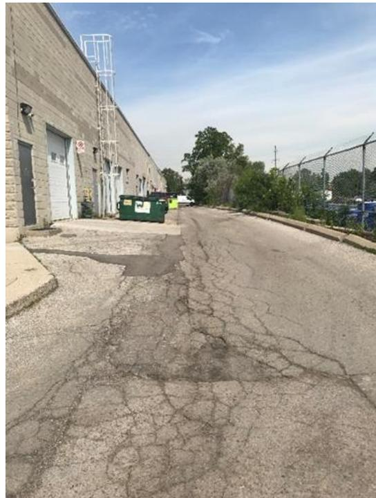
**Figure 48 :** Bitume endommagé par des ruissellements de surface.
