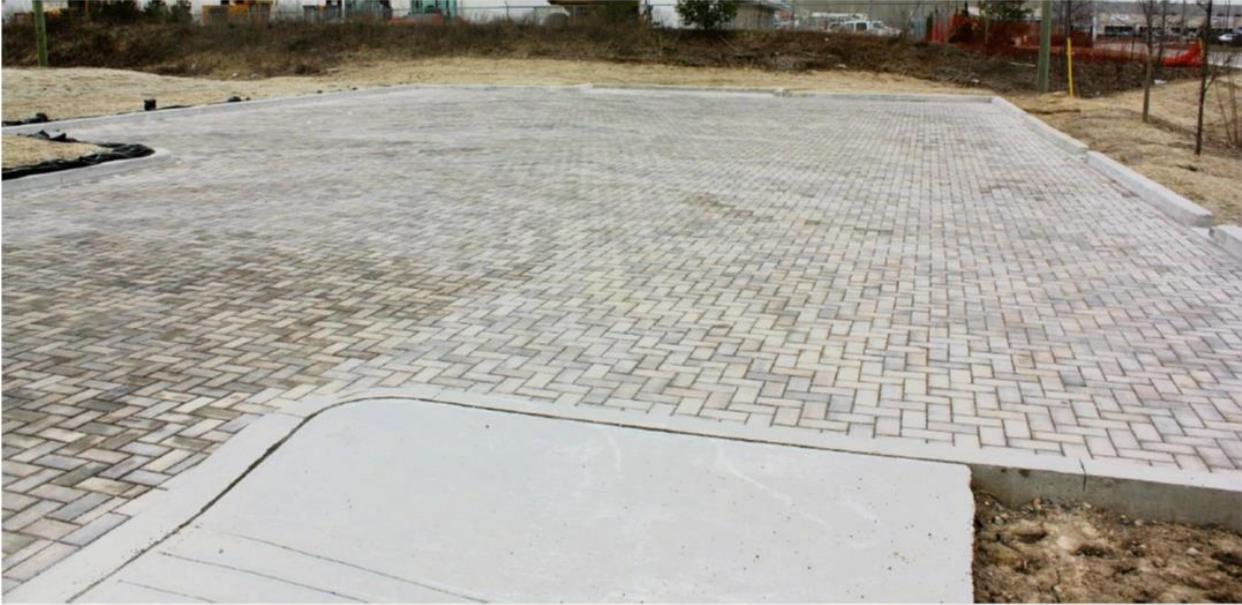
**Figure 20** : Terrain de stationnement en chaussée perméable en cours de construction à la Huron Natural Area.
